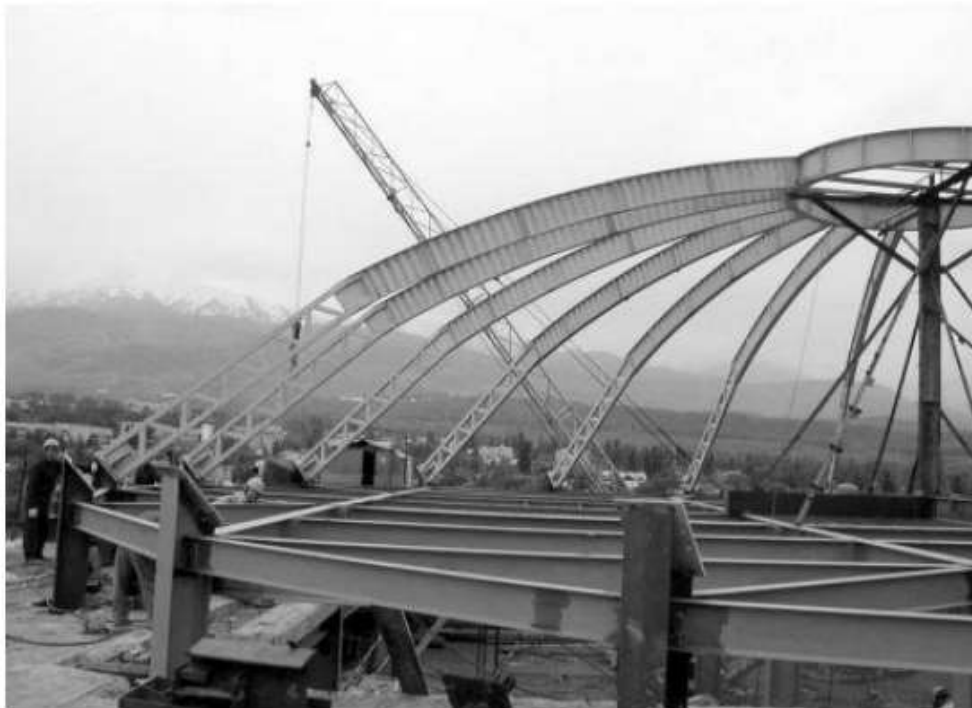
Рисунок 8 - Купол покриття одинадцятиповерхової будівлі бізнес-центру в м. Алма-Ати (Казахстан).
