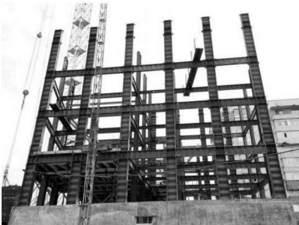
Рисунок 9 – Каркас дев'ятиповерхового житлового будинку в процесі будівництва м. Алма-Ати (Казахстан)
